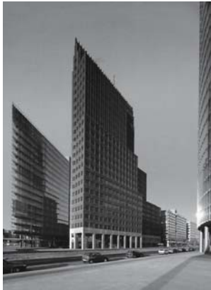
Fig. 1: Hans Kollhoff: High-rise office block, Potsdamer Platz, Berlin (D), 1999
