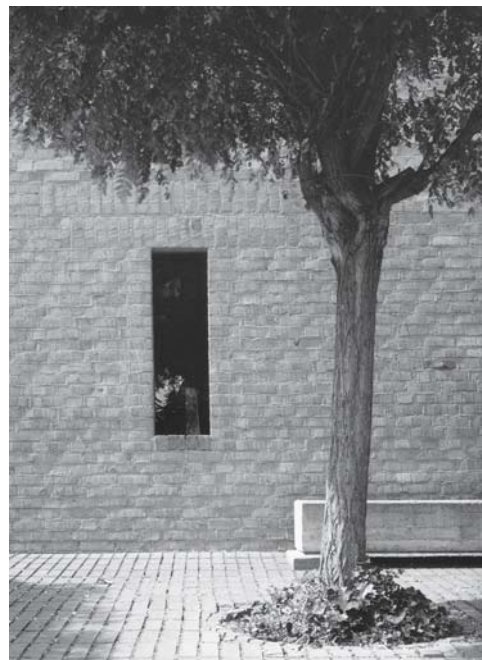
Figure 67: Whitewashed masonry Heinz Bienefeld: Schütte House, Cologne (D), 1980
